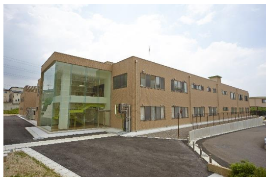
ぬくもりサポート館の写真です 回復期リハ 60 床、神経難病 60 床、重心 50 床、 機能訓練棟が新しくなりました
